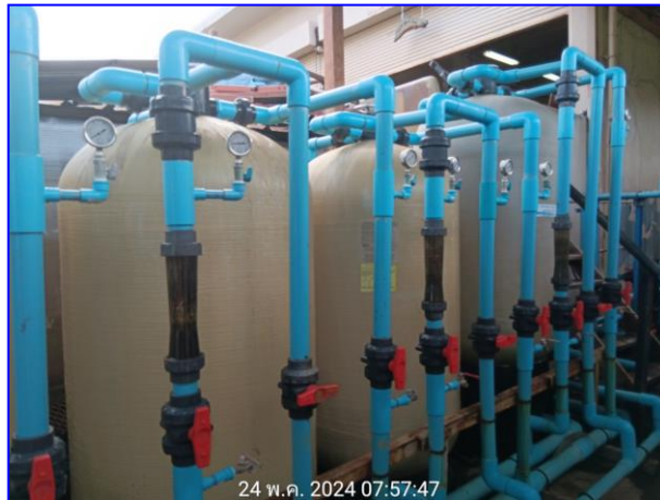
รูปที่ 2.29 ระบบกรองน้ำใช้
